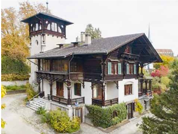
Architektonisches Kleinod: Villa Margaritha in Burgdorf
